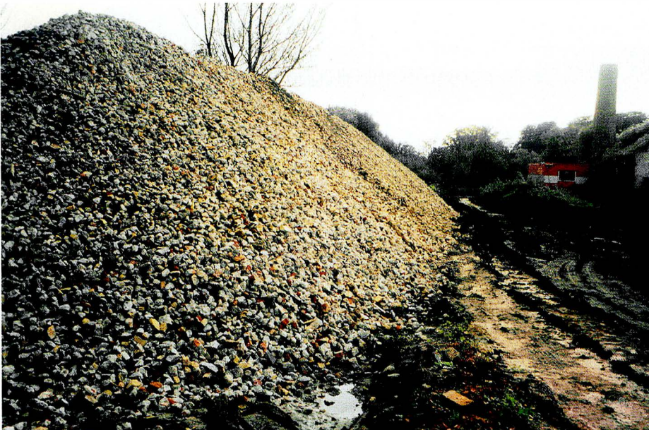
Et af de største flagskibe inden for teglværks- branchen siden midten af 1800-tallet blev nedbrudt til brokker i september 1999 for at skabe plads til ejerlejligheder.
