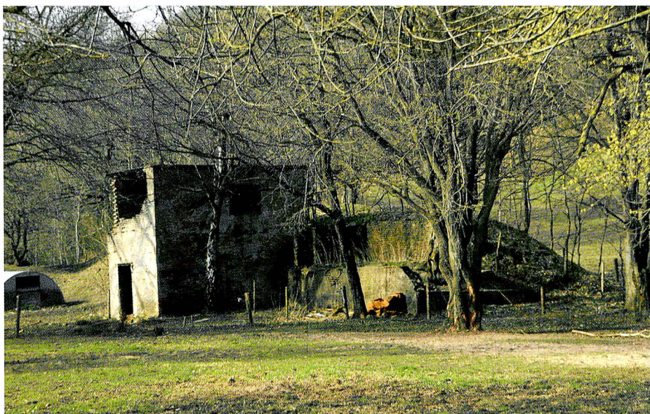
De sidste sør- gelige rester af Lundum Tegl- værk. Motor/ maskinhuset samt enkelte fundamenter ses endnu i 2012.
