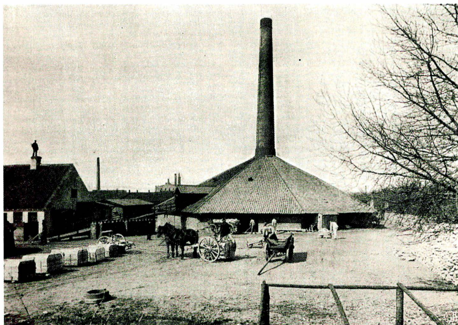
Ringovnen på Horsens Nye Kalkværk. Billedet er fra 1906.
